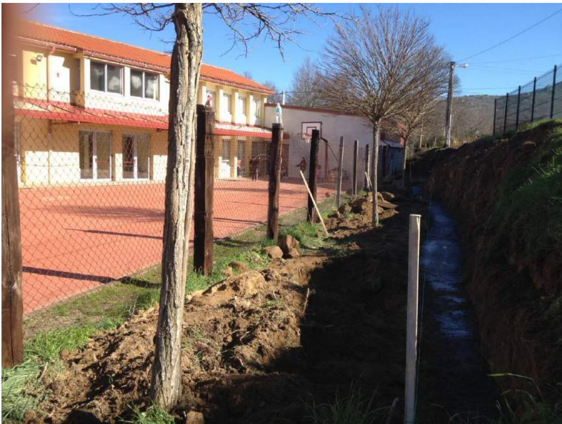
O primeiro tramo da obra fíxose entre xaneiro e febreiro do 2018
