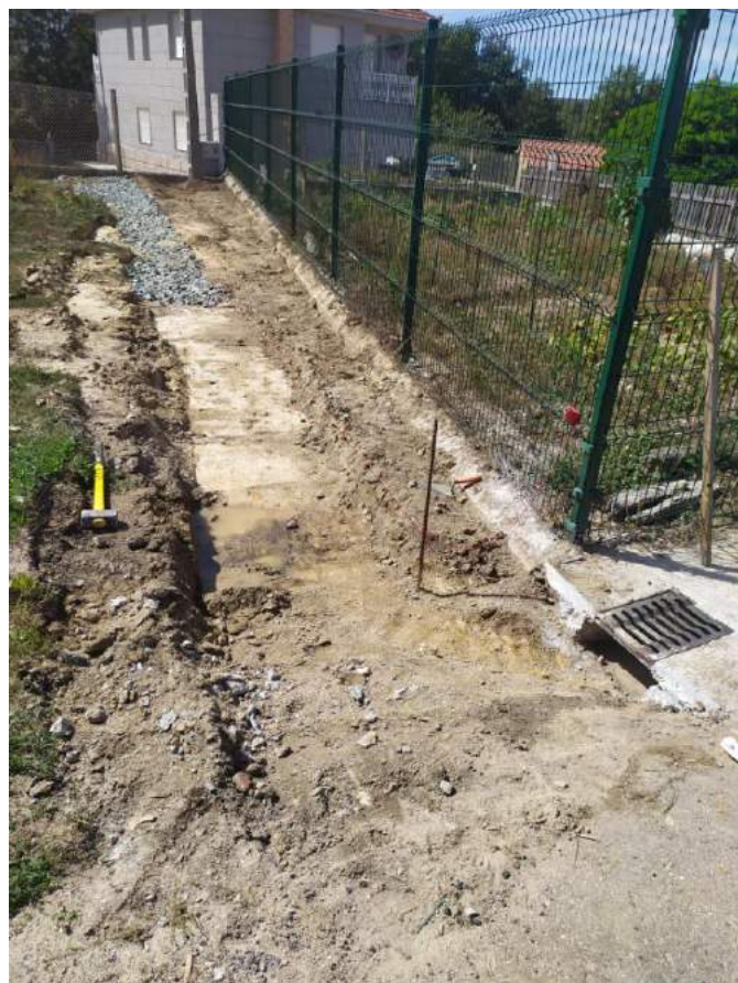
Novas obras de canalización e de zona axardinada exterior. Outubro 2020.
